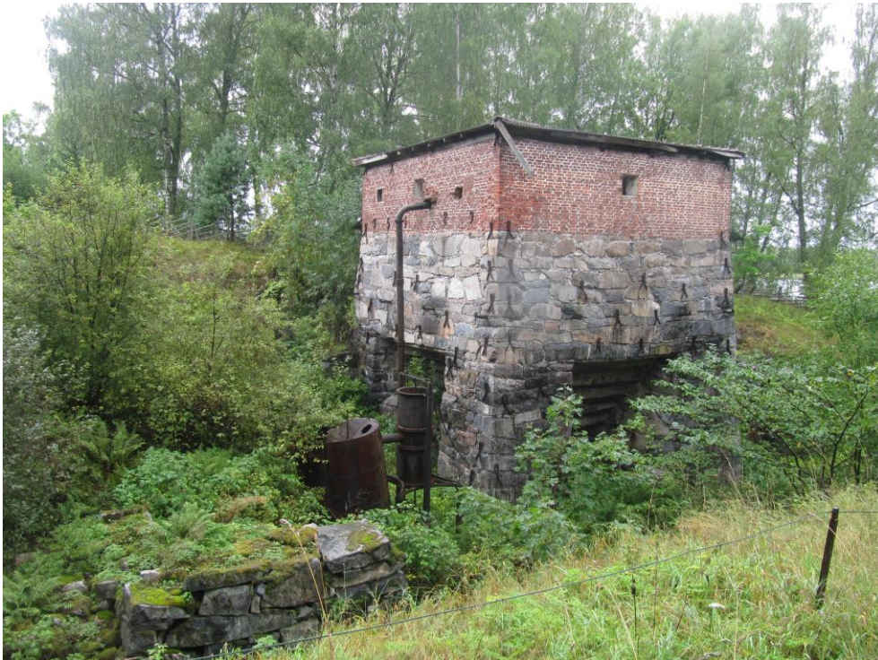
Skogbyn masuuni. Masuunin vierellä on jäänteitä höyrykäyttöisestä puhalluskoneesta. Masuunin alaosassa on kaksi hormirintaa. Vasemmalla puolella puhalluskoneen takana häämöttää puhallusrinta ja oikealla edessä laskurinta. Puhallusrinnan kautta puhallettiin masuuniin ilmaa ja laskurinnan kautta laskettiin valurauta ja kuona.
